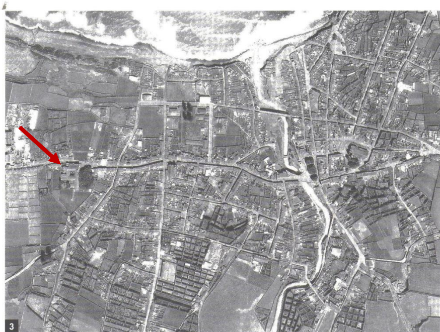
Fig. 15 – Vista aérea da cidade da Ribeira Grande, com a inserção do convento franciscano.
