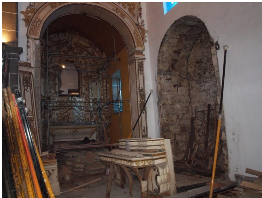
Fig. 48 – Altar dos Terceiros (esquerda) e o nicho do altar de N.ª Sr.ª da Soledade, que se encontrava completamente desmontado aquando da realização deste trabalho. Fotografia de Duarte Nuno Chaves, 2011.
