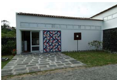
Figura D-321 Aspecto exterior do CCC. Fotografia: Da autora. 2008.
