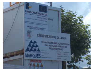
Figura D-148 Aspecto obras do novo espaço para o museu do presépio. Fotografia: Da autora. 2009.
