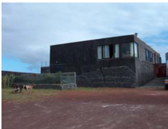
Figura D-241 Aspecto exterior do OVGA. Fotografia: Da autora. 2009.
