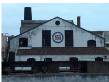
Figura D-361 Aspecto exterior da Fábrica SINAGA – Antiga Sala Ensacamento Fotografia: Da autora. 2008.
