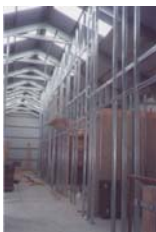
Figura D-223 Aspecto da construção da estrutura da 2ª fase (rua) Fotografia: Da autora. 2002.
