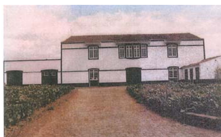
Figura D-86 Aspecto exterior da Fábrica de Chá da Mafoma. Fotografia: Melo, 2008.
