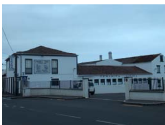
Figura D-156 Aspecto exterior. Fotografia: Da autora. 2008.
