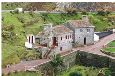
Figura D-339 Aspecto do parque. Fotografia: www.cm-nordeste.pt Último acesso em 2009-01-15. Janeiro 2006
