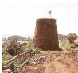
Figura D-265 Aspecto exterior do Moinho de Vento da Tia Faleira antes da intervenção de recuperação Fotografia: espólio da Junta de Freguesia da Fajã de Cima. Século XX.
