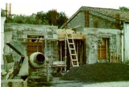
Figura D-167 Aspecto da construção do edifício. Fotografia: Espólio Gilberto Bernardo. 1992.
