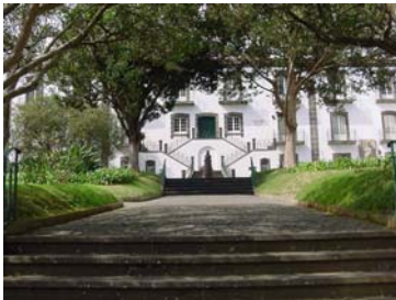
Figura D-1 Aspecto exterior do Museu Carlos Machado - Edifício Sede.
