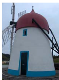
Figura D-269 Aspecto exterior do Moinho de Vento da Tia Faleira depois da intervenção de recuperação Fotografia: Da autora. 2009.
