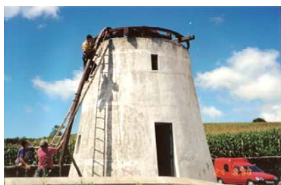
Figura D-266 Aspecto do Moinho de Vento da Tia Faleira - fase de recuperação. Fotografia: Espólio da Junta de Freguesia da Fajã de Cima. 2000.
