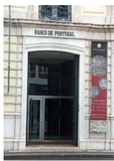
Figura D-344 Aspecto exterior do edifício do Banco de Portugal em Ponta Delgada Fotografia: Da autora. 2008.
