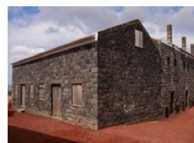
Figura D-290 Aspecto exterior Fotografia: Da autora. 2009.
