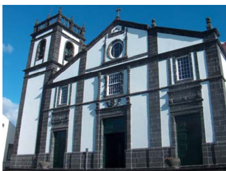
Figura D-385 Aspecto exterior da Igreja de Nossa Senhora da Conceição Fotografia: Da autora. 2009.
