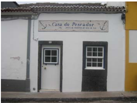
Figura D-294 Aspecto exterior Casa do Pescador de Água de Pau.
