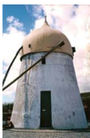
Figura D-268 Aspecto do Moinho de Vento da Tia Faleira - fase de recuperação. Fotografia: Espólio da Junta de Freguesia da Fajã de Cima. 2000.
