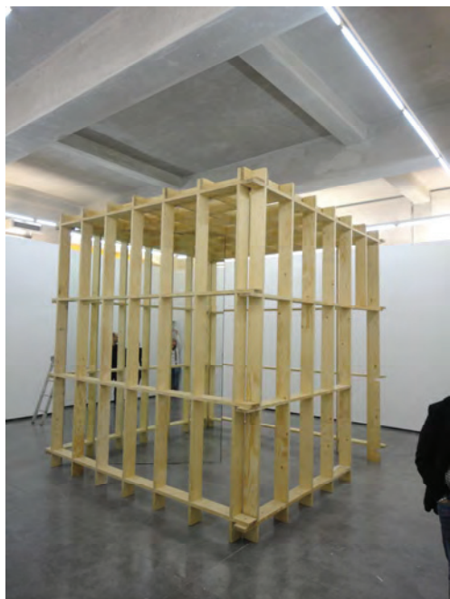
Figura 94. Montagem do espaço temporário do EMPTY CUBE.
