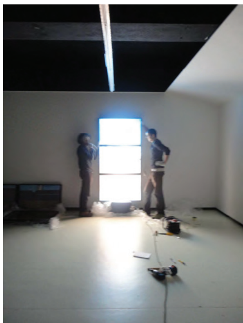
Figura 33. Teste do sistema elétrico da peça Sem título (da série An Ocean Between Us) , 2013, composta por 13 caixas de luz.
