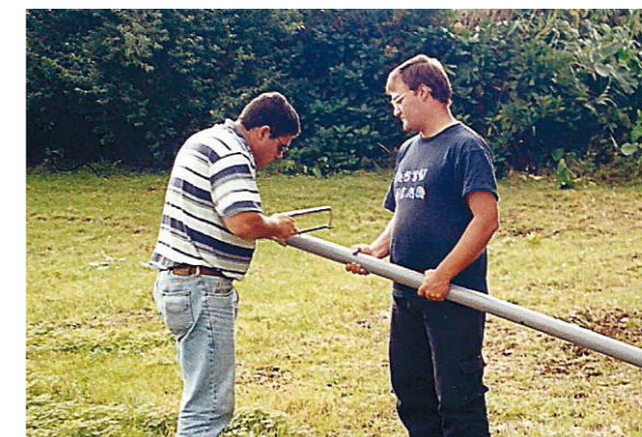
Instalação de um piezómetro na margem da Lagoa das Sete Cidades
