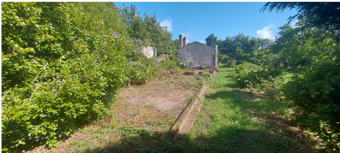
Figura A-8 - Aquartelamento da formação sanitária do HMC4, Boa Vista
