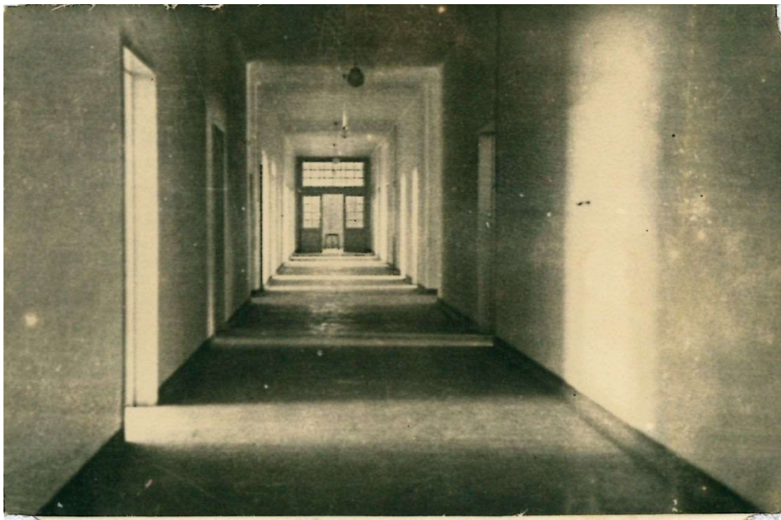
Figura E-5 - Corredor de ligação do HMT1, Terra Chã
