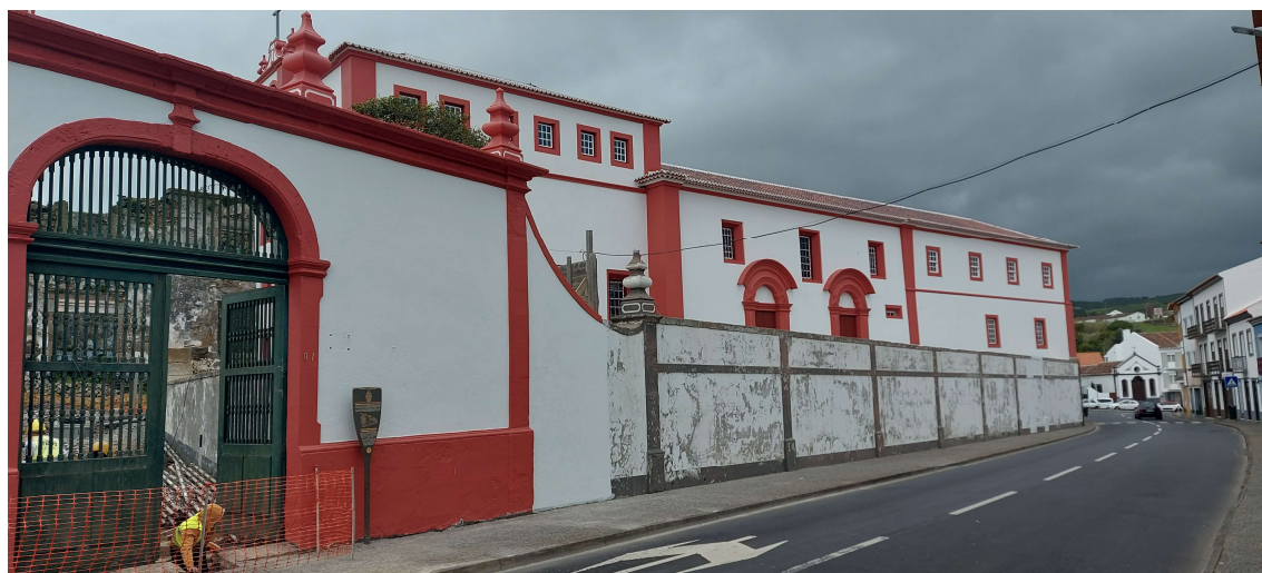
Figura A-12 - Fachada principal do Convento das Concepcionistas, antigo Hospital Militar da Terceira, após trabalhos de reabilitação.
