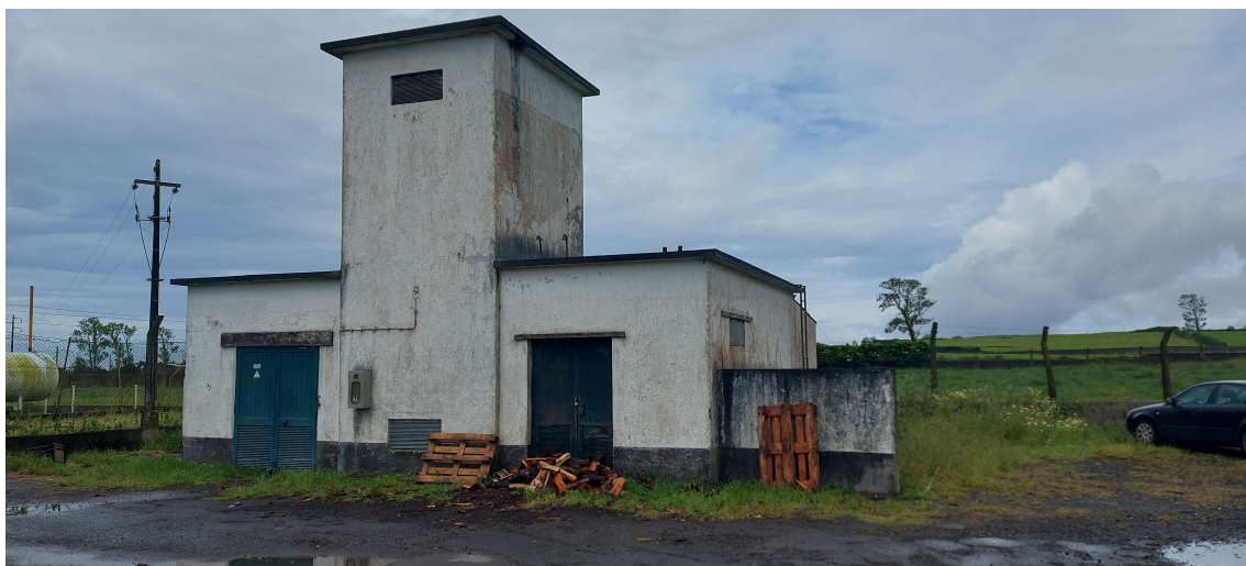
Figura A-4 - Central elétrica do antigo HMT1, nos Arrifes
