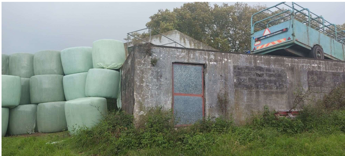
Figura A-7 - Cave que serviu de casa mortuária, sala de autópsias e arrecadação de material do HMC3, Vila Franca do Campo
