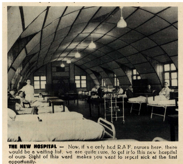
Figura 41- Notícia com a imagem do interior do novo hospital britânico.
