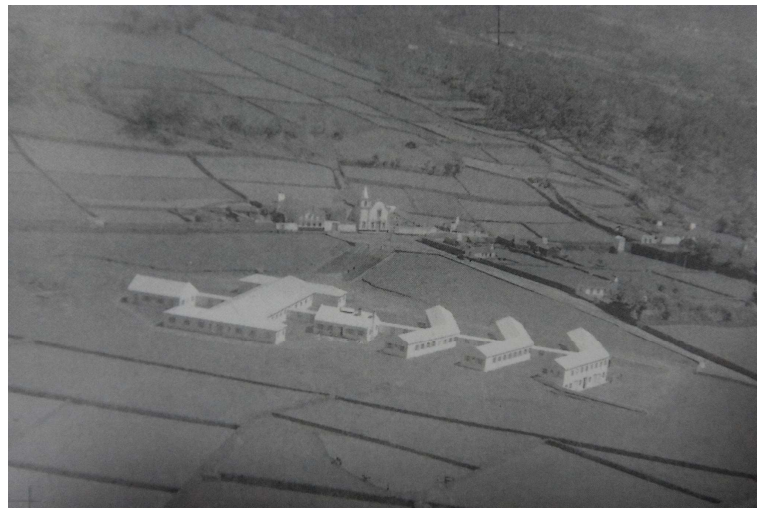
Figura 36 - Vista aérea do HMT1, na Terra Chã.
