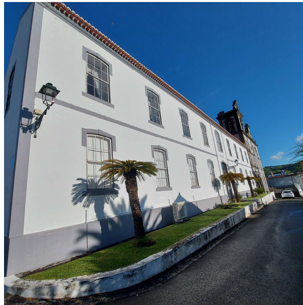
Figura 44 - Fachada principal do Hospital Militar do Faial
