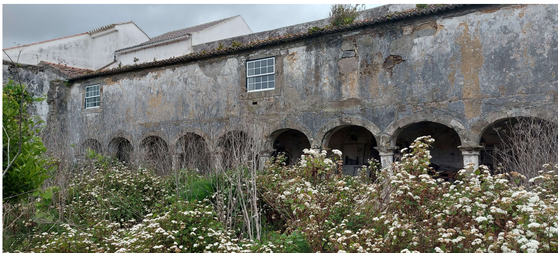
Figura A-13 - Claustro do Convento das Concepcionistas, antigo Hospital Militar da Terceira
