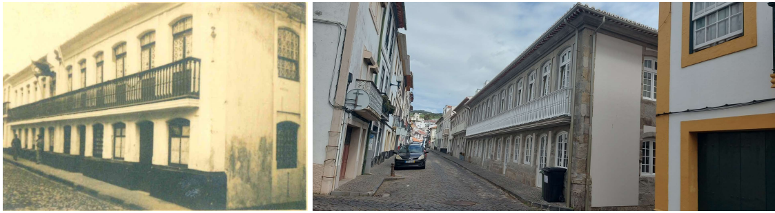
Figura 28 - Imagem antiga e atual do edifício onde foi instalada a Direção e Aquartelamento do Hospital Militar da Terceira
