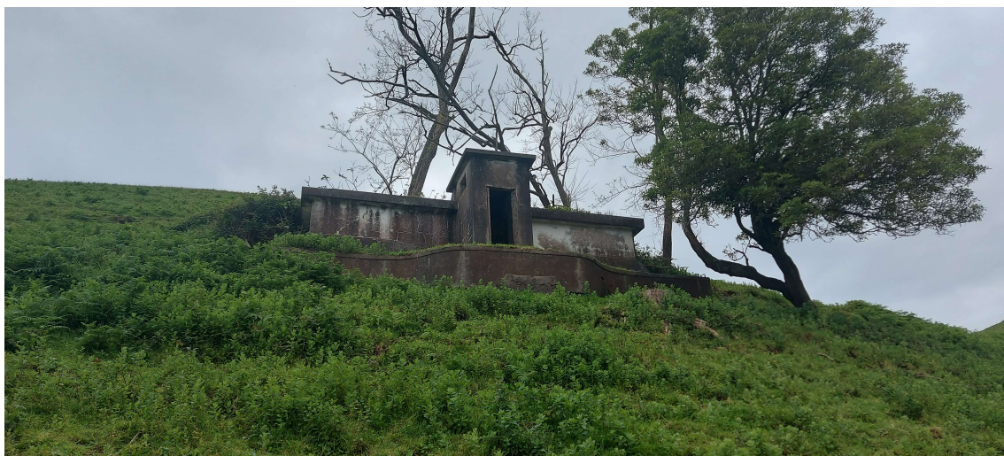
Figura A-16 - Tanque de abastecimento de água do HMT, no Faial, o último resistente do hospital
