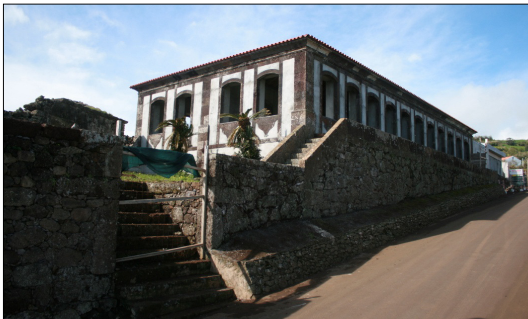
Ilustração 25 - Casa dos Tiagos, vila do Topo, durante a reabilitação
