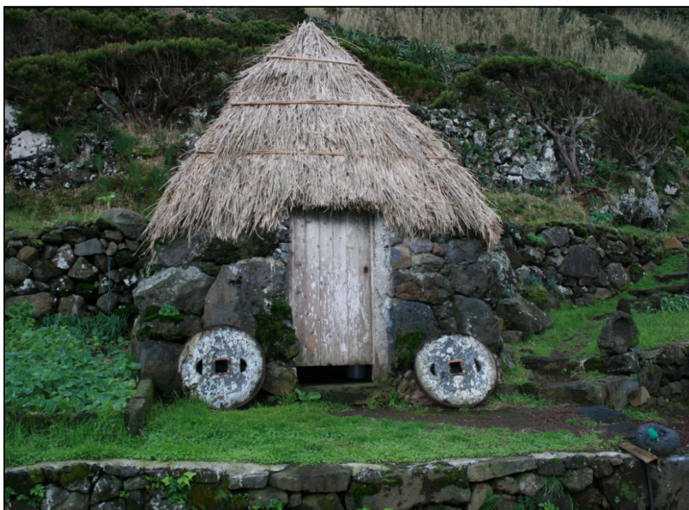
Ilustração 12 - Cafua localizada na Fajã do Mero (com tecto de cana, construído em 1973 sobre estrutura em pedra já existente)
