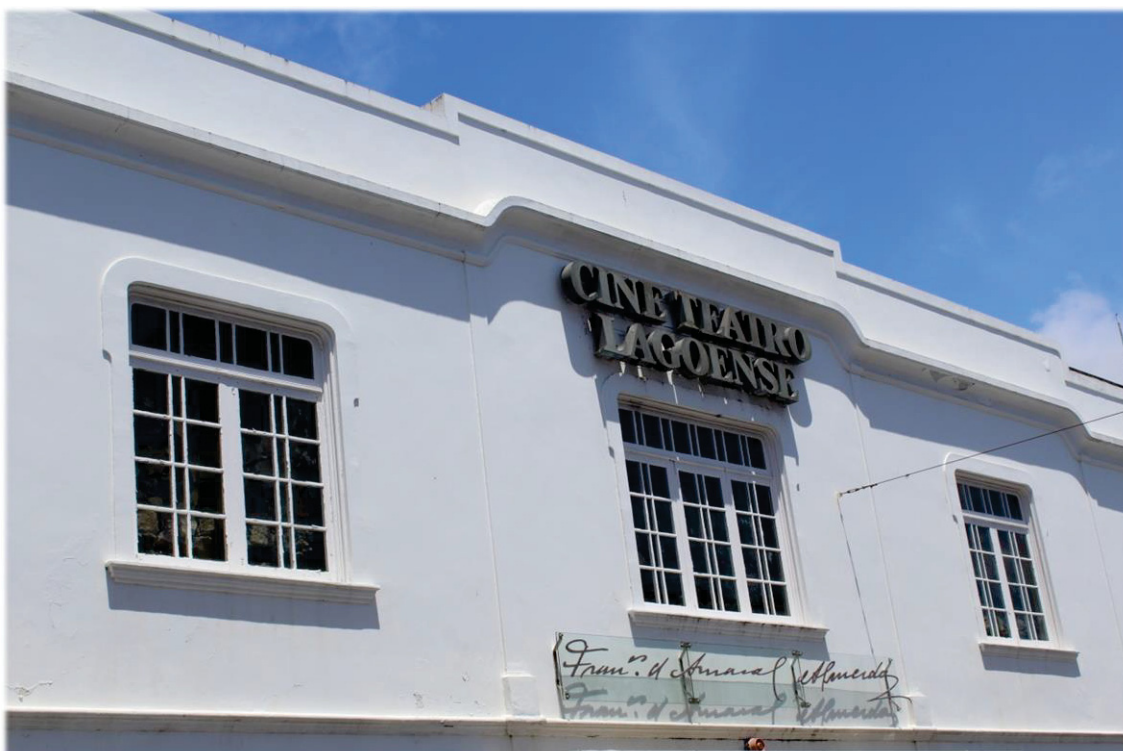
Figura 30 – Fachada do Cine Teatro Lagoense Francisco d’Amaral Almeida, 2017 Fonte: Própria
