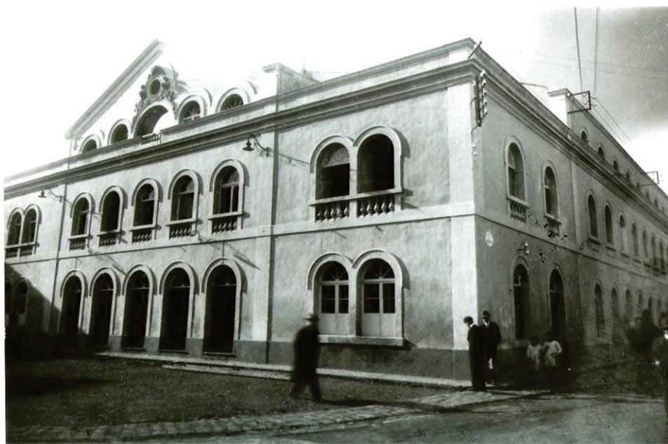
Figura 4 – Fachada principal e lateral do Teatro Micaelense, s/d Fonte: https://www.flickr.com/photos/filipefranco/6976074465/in/photostream/
