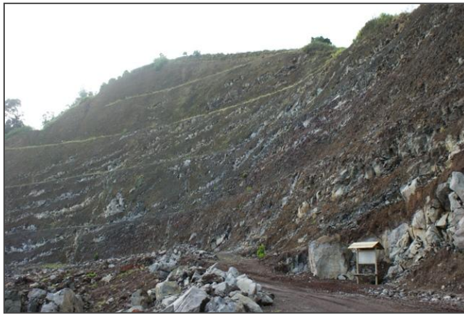
Figura 4 – Início do acesso à Fajã do Calhau com os taludes rochosos rasgados na falésia costeira.
