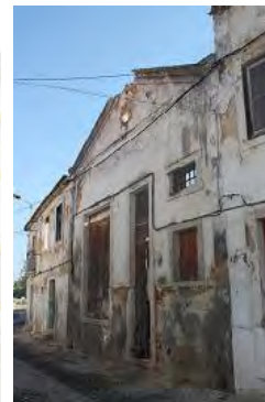
Figura 31 – Edifício (clube de canoagem)
