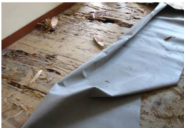
Figura 9: Exemplo de uma infestação destrutiva em que é necessária a substituição total das madeiras.
