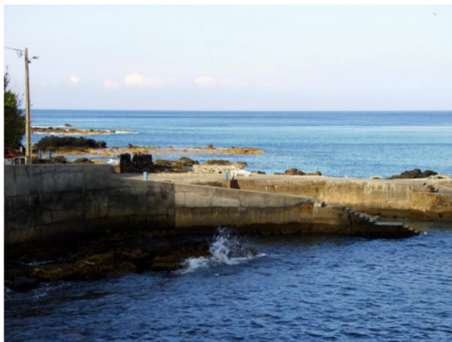
Figura 51 - Forte da baía de São Lourenço: ao centro, à esquerda, vestígios da antiga muralha (Foto do autor, junho de 2008.)
