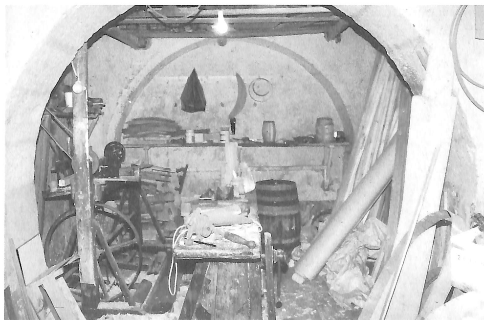
Foto 6 - Interior da oficina (compartimento norte), antes das obras de limpeza e conservação.
