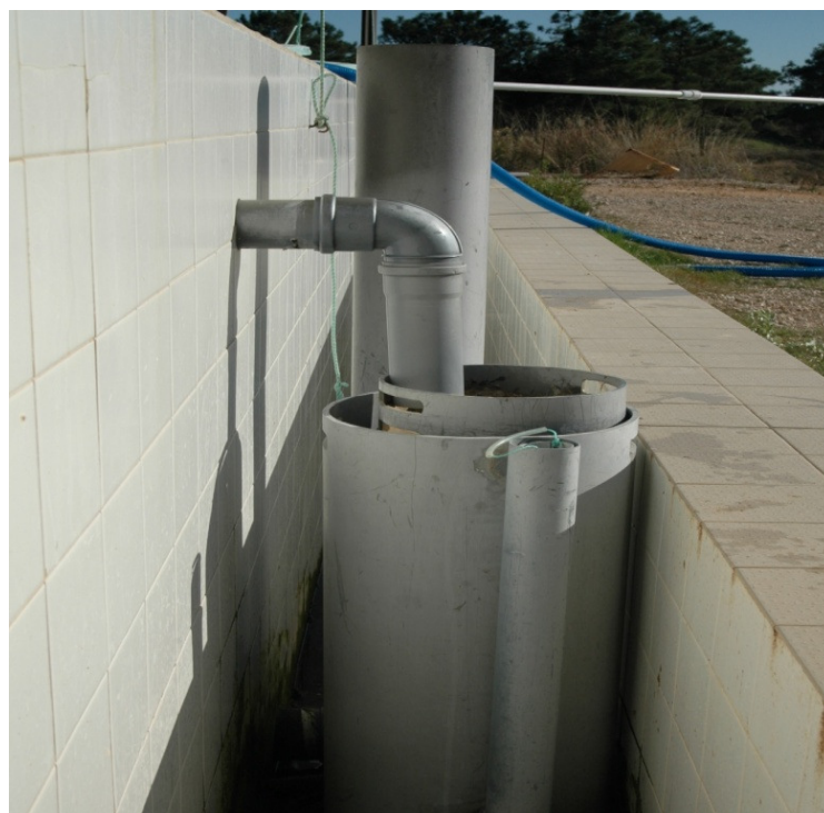
Figura 8: Um dos coletores externos de ovos junto a um dos tanques utilizados no ensaio.
