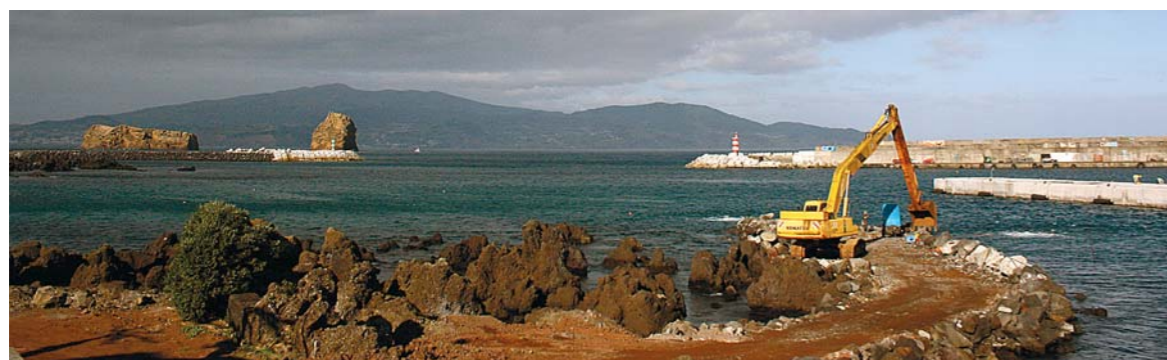
Figura 2. Obras no novo Terminal Marítimo de Passageiros do Porto da Madalena, na Ilha do Pico. Fotografia: Eva Cacabelos
