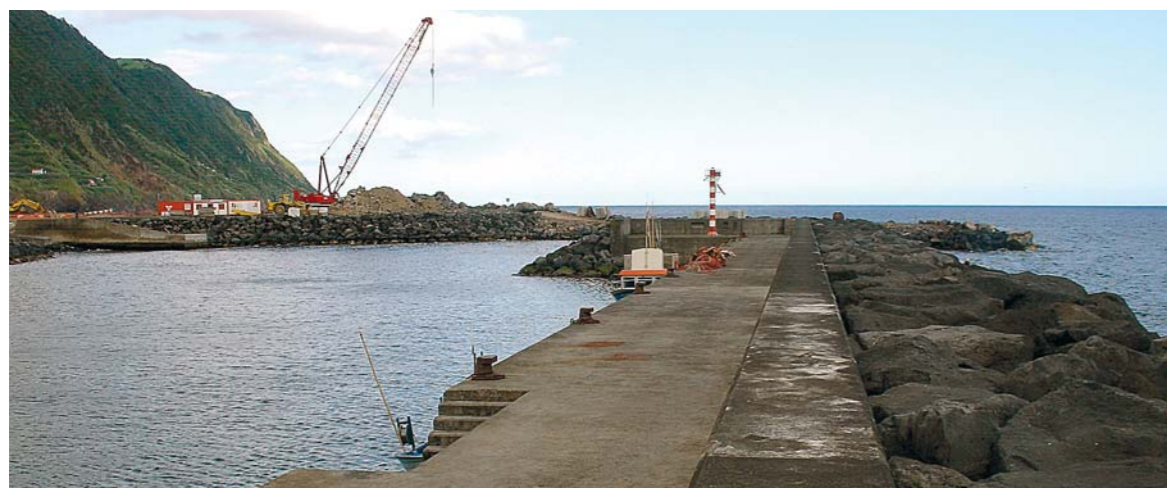
Figura 1. Obras no novo Porto da Povoação, na Ilha de São Miguel. Fotografia: Eva Cacabelos
