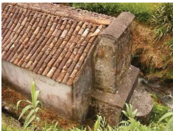
Figura 224. Moinho 2. Edifício anexo com forno de volume exterior de planta semicircular com chaminé retangular.
