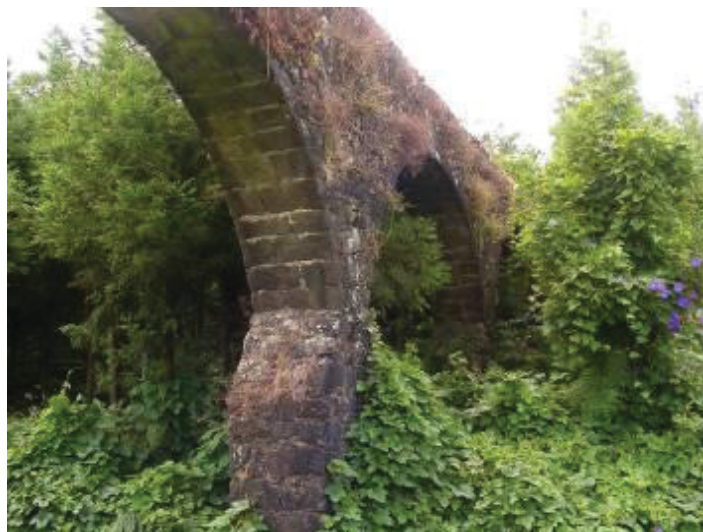
Figura 310. Aqueduto. Pormenor da cantaria de aparelho isódomo em redor do arco.
