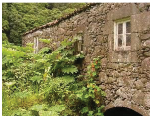
Figura 274. Moinho 7. Fachada principal. Arco de volta perfeita.
