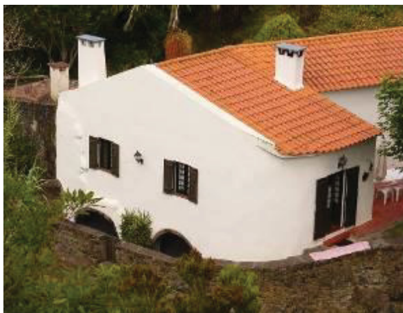
Figura 212. Moinho 5. Fachada principal. Pormenor dos dois aros de volta perfeita.
