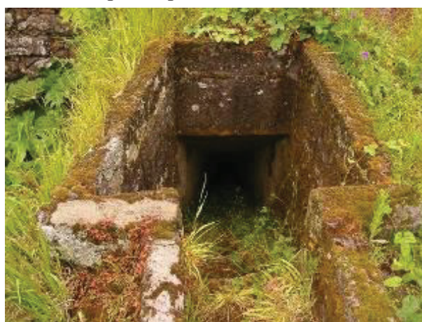
Figura 279. Moinho 7. Cubo de perfil quadrado construído em cantaria.
