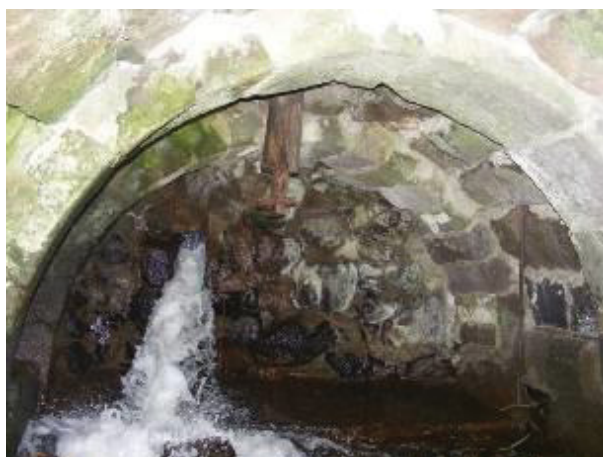
Figura 250. Moinho 2. Interior do cabouco. Arcos de volta perfeita em cantaria de pedra à vista. Ao centro, veio em madeira.
