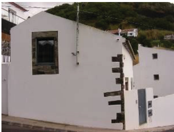
Figura 202. Moinho 2. Fachada esquerda virada à via pública.
