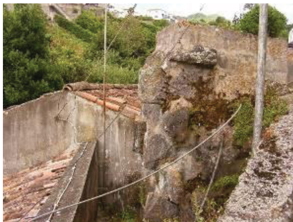
Figura 223. Moinho 2. Levada e cubo em alvenaria de pedra à vista.
