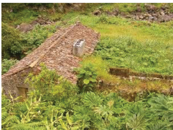
Figura 277. Moinho 7. Enquadramento geral.
