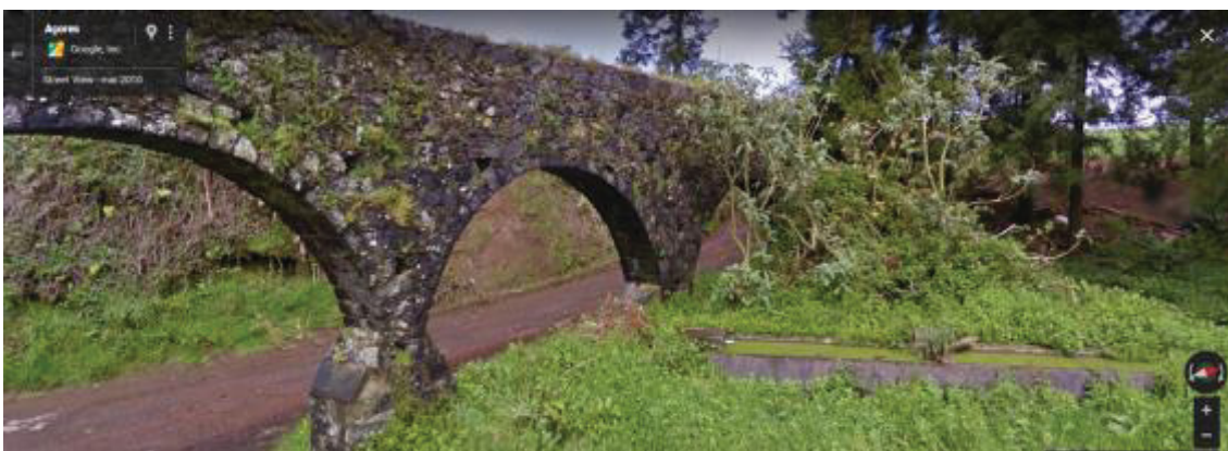
Figura 315. Aqueduto. Tanques. Pilar sem intervenção. Maio 2010.
