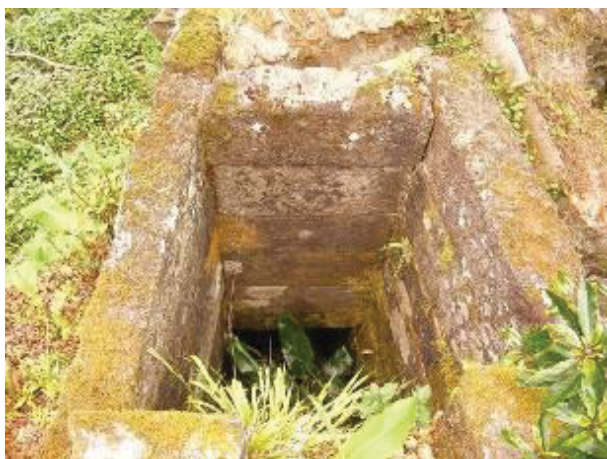
Figura 270. Moinho 6. Cubo esquerdo de perfil quadrado construído em cantaria.
