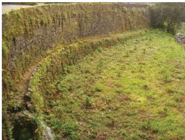
Figura 239. Levada em alvenaria de pedra à vista.
