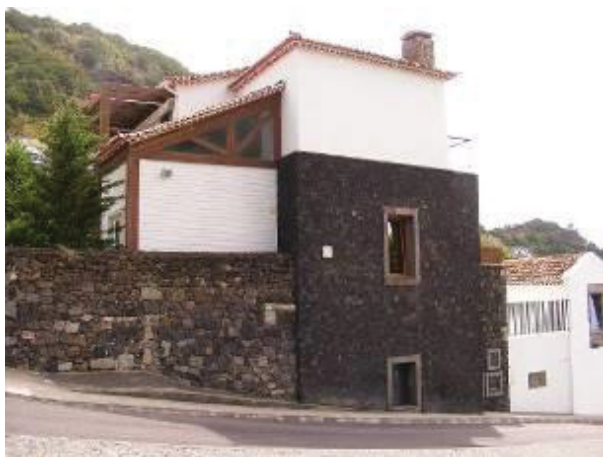
Figura 200. Moinho 1. Fachada virada à via pública.
