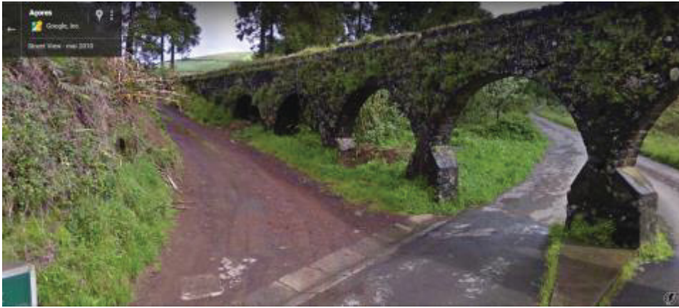
Figura 316. Aqueduto. Pilar sem intervenção. Maio de 2010.
