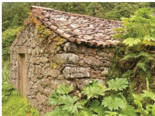
Figura 276. Moinho 7. Fachada direita.
