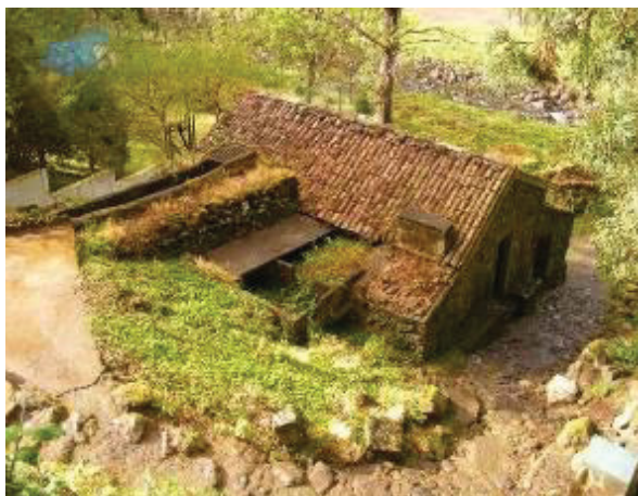
Figura 263. Moinho 5. Enquadramento geral.
