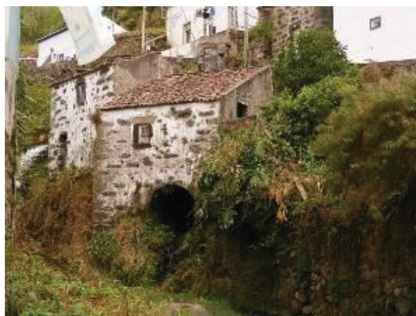
Figura 220. Moinho 2. Fachada principal. Pormenor do arco de volta perfeita.
