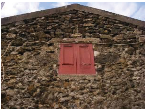
Figura 210. Moinho 4. Pormenor do vão na fachada virada à via pública.
