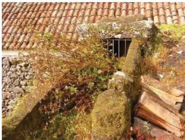
Figura 257. Moinho 4. Levada e cubo em alvenaria de pedra a vista.
