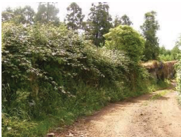
Figura 307. Aqueduto coberto com densa vegetação.
