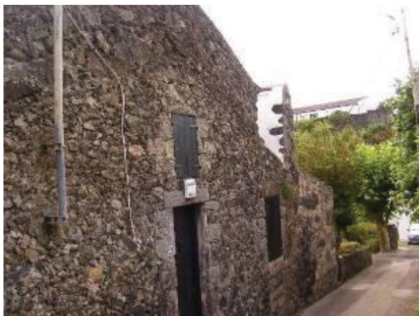
Figura 205. Moinho 3. Fachada esquerda virada à via pública.
