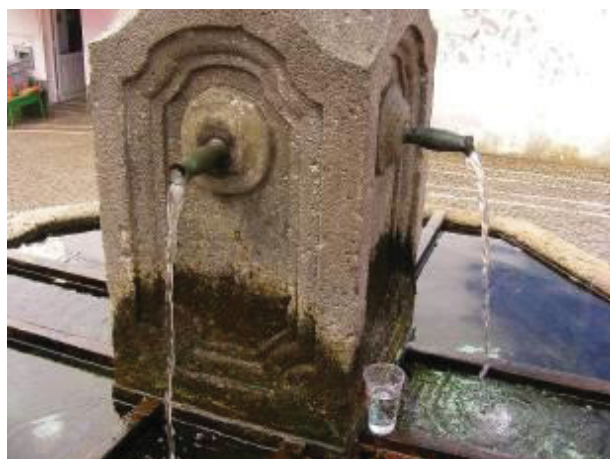
Figura 193. Pormenor das bicas metálicas e réguas de apoio ao vasilhame.
