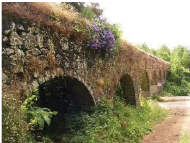
Figura 306. Aqueduto. Arcos abatidos.
