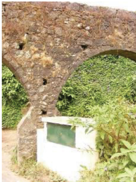
Figura 312. Aqueduto. intervenção junto ao pilar.
