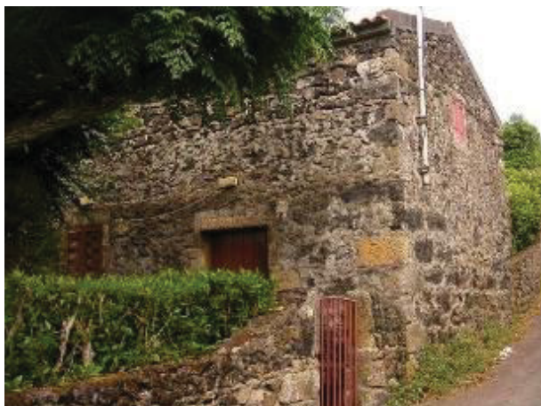
Figura 208. Moinho 4. Fachada principal e fachada paralela a via pública.
