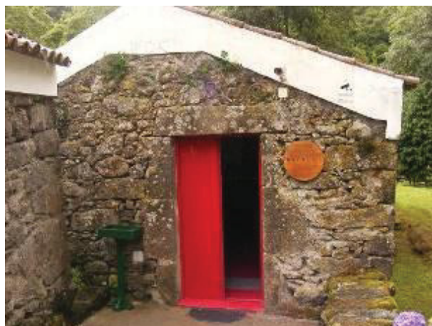
Figura 254. Moinho 4. Fachada principal. Atual edifício de receção do parque de campismo.
