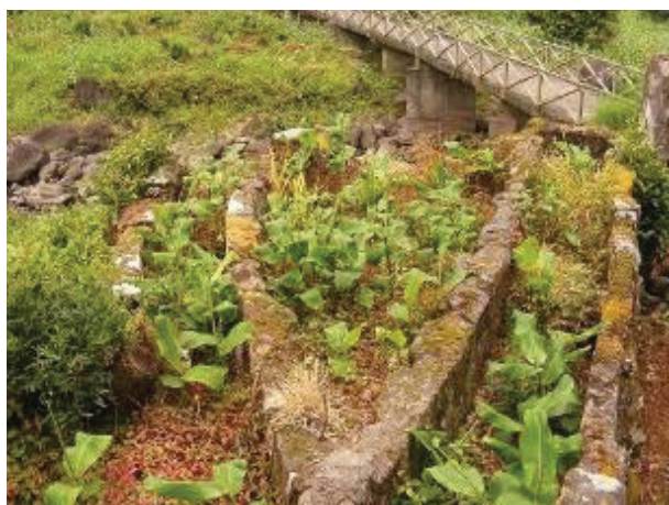
Figura 268. Moinho 6. Levadas em alvenaria de pedra à vista.
