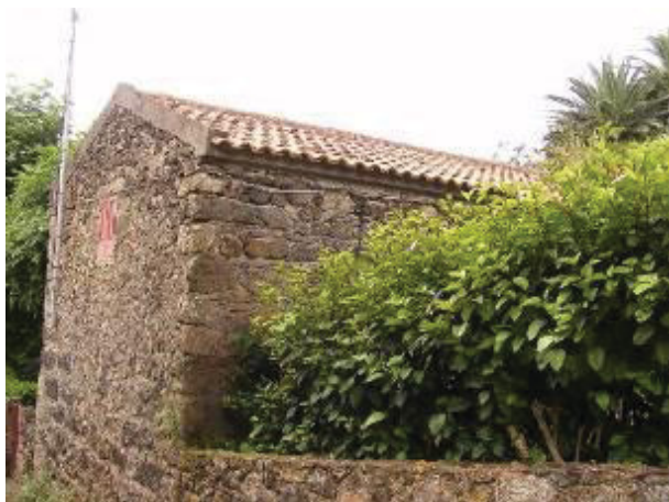
Figura 211. Moinho 4. Fachada traseira e fachada paralela à via pública.
