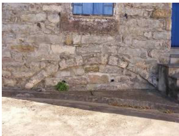
Figura 234. Fachada principal. Vestígio de arco de volta perfeita.
