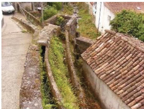
Figura 223. Moinho 2. Levada e cubo em alvenaria de pedra à vista.
