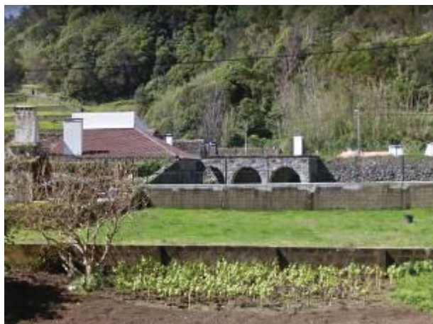
Figura 236. Vestígios de aqueduto em alvenaria de pedra à vista.
