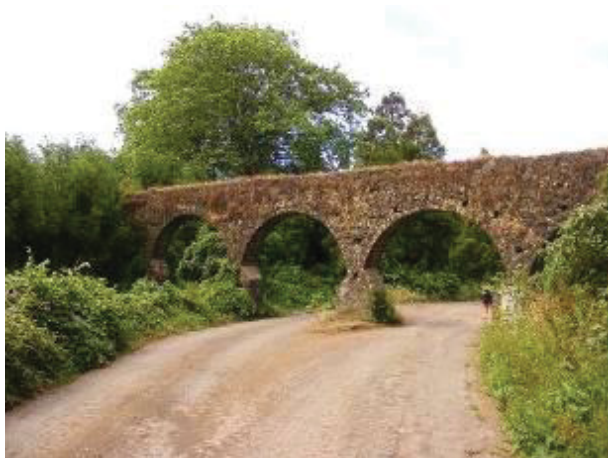
Figura 308. Aqueduto. Arcos abatidos e caminho rural Grota da Figueira.
