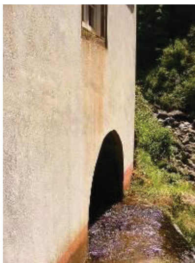
Figura 247. Moinho 2. Fachada virada ao percurso de água. Arco de volta perfeita.
