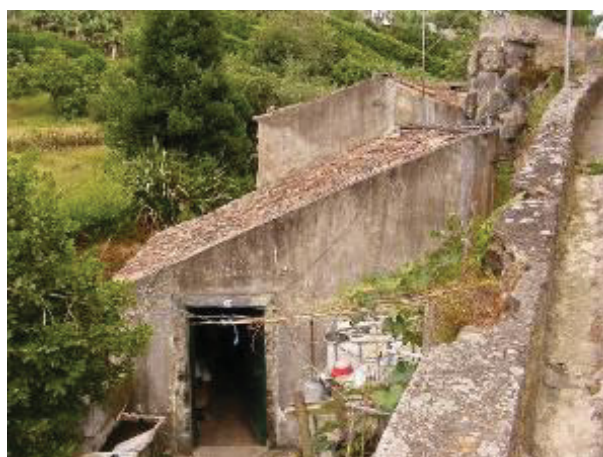
Figura 221. Moinho 2. Fachada direita com vão com moldura em cantaria.
