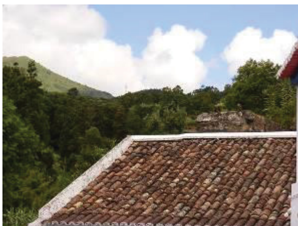
Figura 217. Moinho 1. Pormenor do cubo em alvenaria de pedra a vista e cobertura de telha de meia cana.
