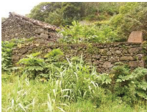
Figura 278. Moinho 7. Fachada esquerda e pequeno edifício construído em alvenaria de pedra à vista.
