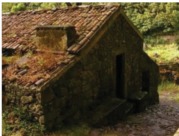
Figura 261. Moinho 5. Fachada esquerda.
