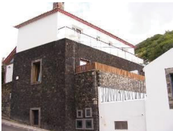
Figura 201. Moinho 1. Fachada virada à via pública.
