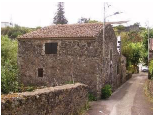
Figura 206. Moinho 3. Fachada traseira e fachada esquerda virada à via pública.
