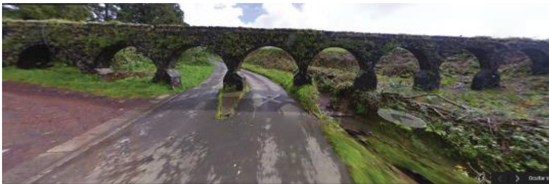
Figura 314. Aqueduto. Arcos abatidos. Caminho rural Grota da Figueira. Ribeira do Fecha Dentes. Maio de 2010.
