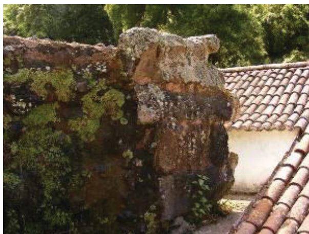
Figura 249. Moinho 2. Cubo em alvenaria de pedra à vista.
