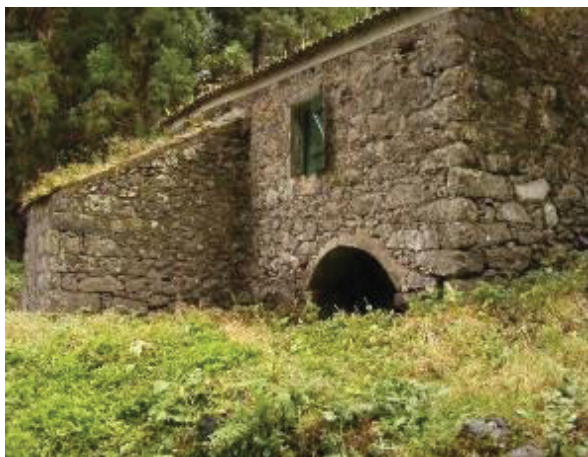
Figura 260. Moinho 5. Fachada principal. Arco de volta perfeita.
