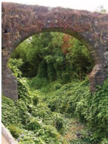
Figura 309. Aqueduto. Arco abatido. Ribeira do Fecha Dentes.
