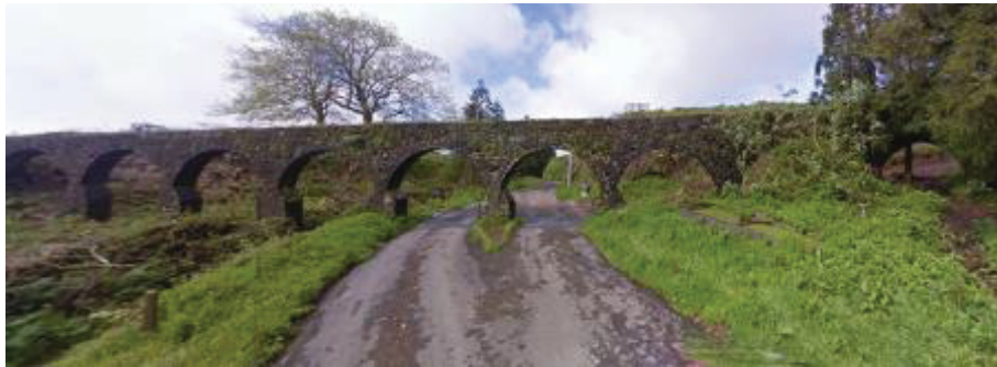
Figura 313. Aqueduto. Arcos abatidos e tanques. Maio de 2010.
