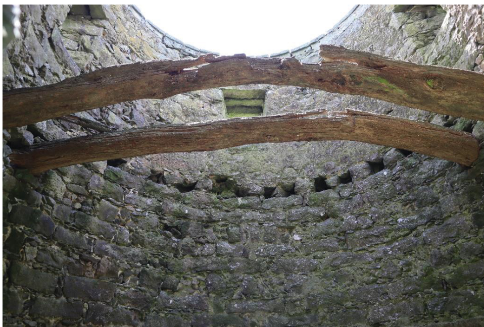
Figura 33: Antigas madeiras de sustentação do piso superior do Moinho da Canada Créditos fotográficos de José Frias 2020
