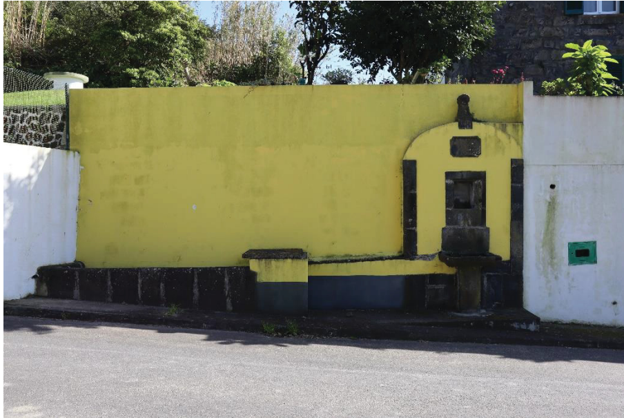
Figura 42: Fontanário da Lomba de Cima Créditos fotográficos de José Frias 2020
