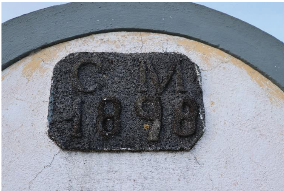
Figura 41: Placa datada do Fontanário da Canada Créditos fotográficos de José Frias 2020
