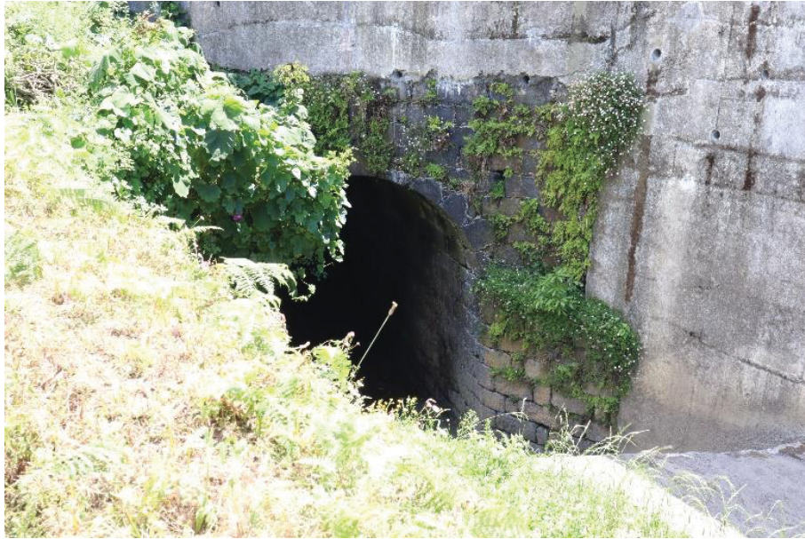
Figura 58: Túnel Créditos fotográficos de José Frias 2020
