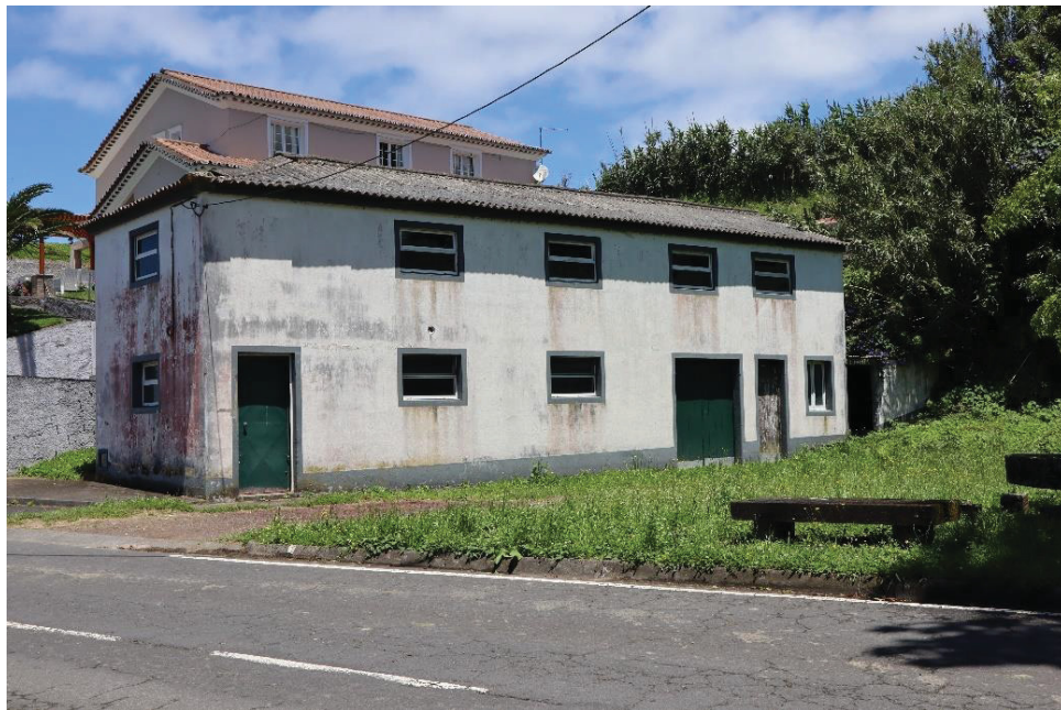
Figura 5: Edifício da antiga Moagem Elétrica de Ginetes Créditos fotográficos de José Frias 2020
