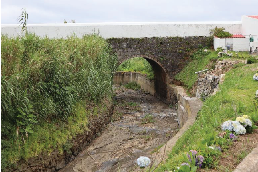
Figura 57: Ponte pedonal Créditos fotográficos de José Frias 2020
