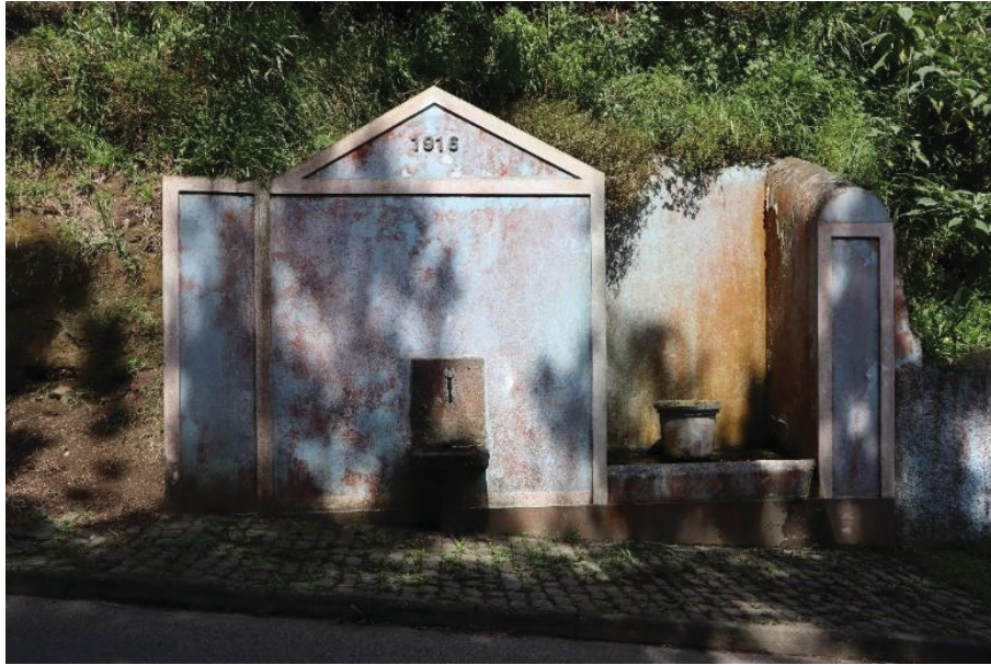
Figura 36: Fontanário da Rua do Alqueive Créditos fotográficos de José Frias 2020
